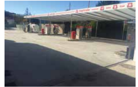
Estación de servicio AVIA
