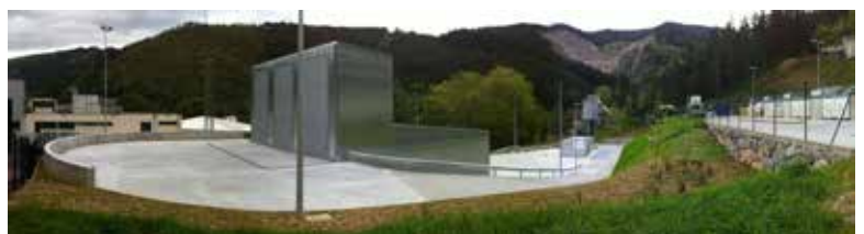
Estación de Transferencia Debabarrena
